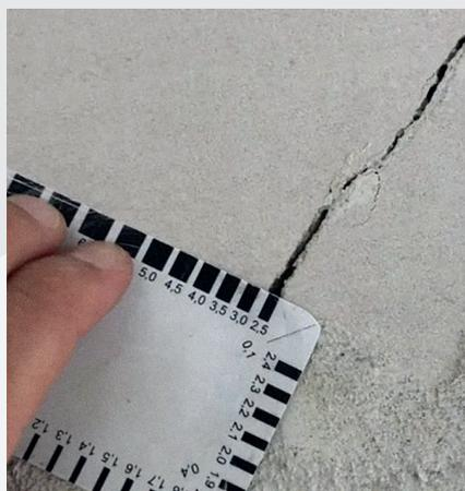
Überprüfung mit Hilfe einer Rissbreitenkarte, ob ein Riss breiter wird oder ob die Rissbildung abgeschlossen ist.
